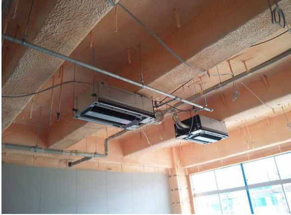
天井機器取付
