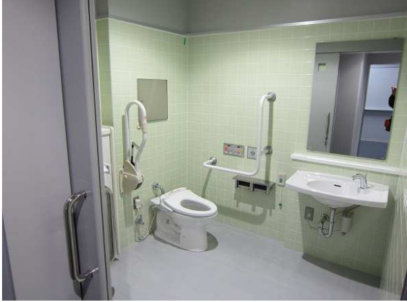
衛生器具取付工事
