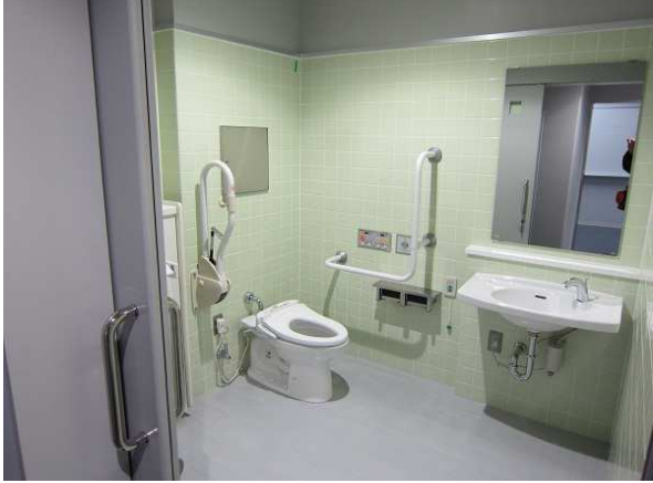
衛生器具取付工事
