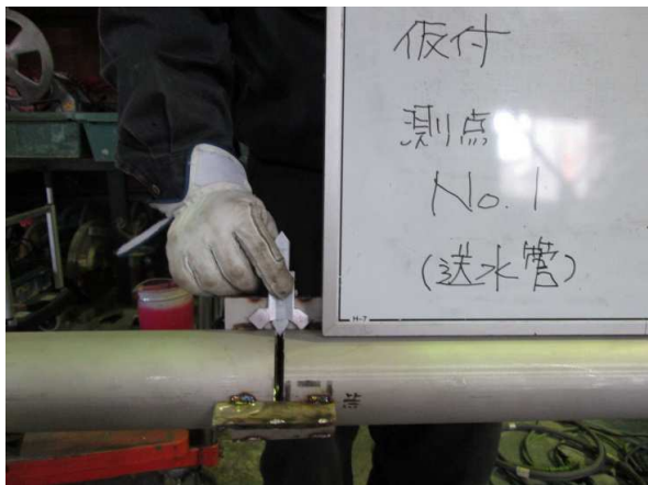
ステンレス管 バックシールド施工 裏波溶接
